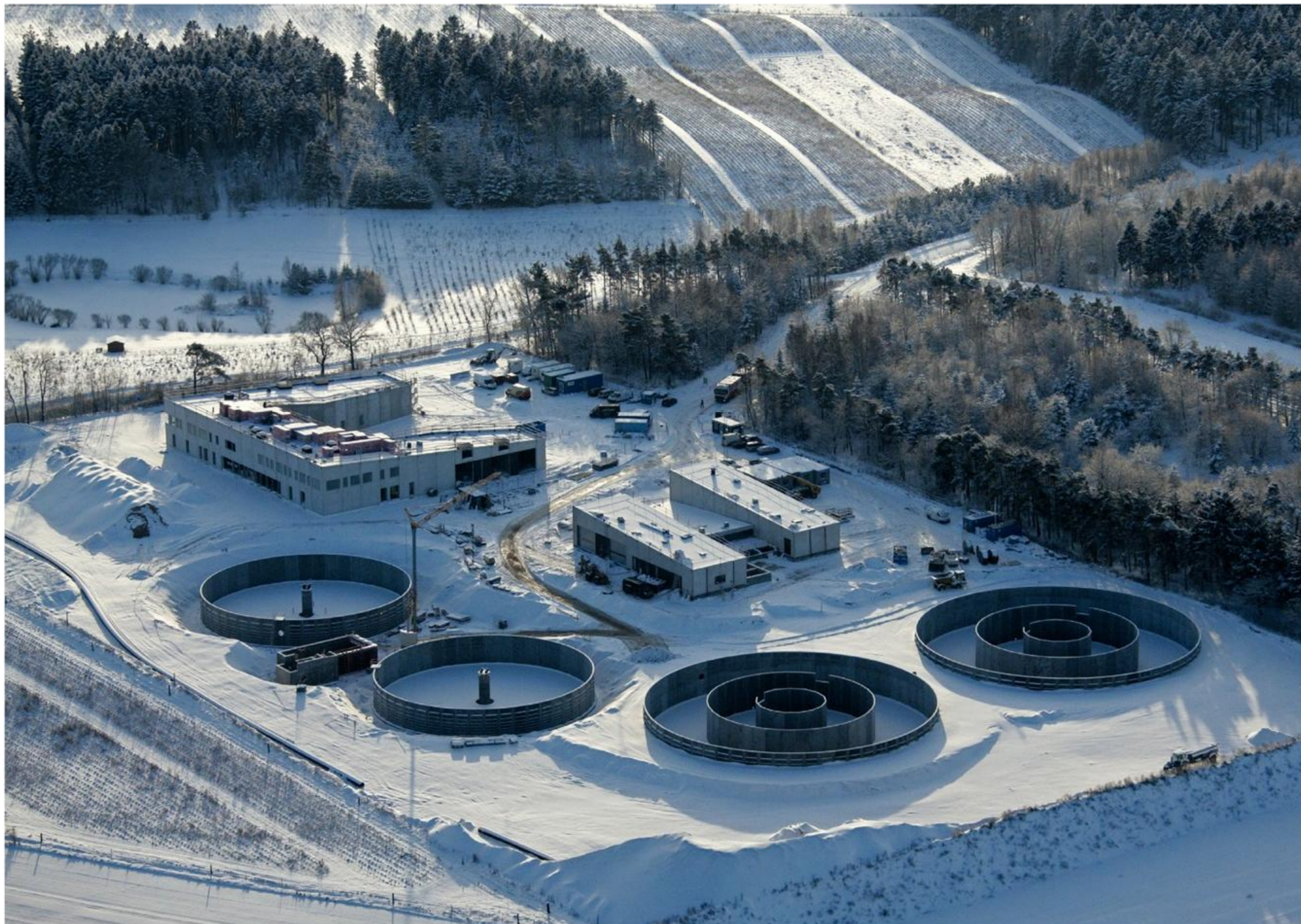
Procestankene er opbygget efter »EnviFlex-princippet«, hvilket vil sige en tre-delning af procestanken med både anaerobe, anoxiske og aerobe tankafsnit. Procestankene har i øvrigt hver en diameter på 45,7 meter og er dermed blandt de allerstørste cirkulære tanke i Danmark. (Foto: BioDane Luftfoto).
