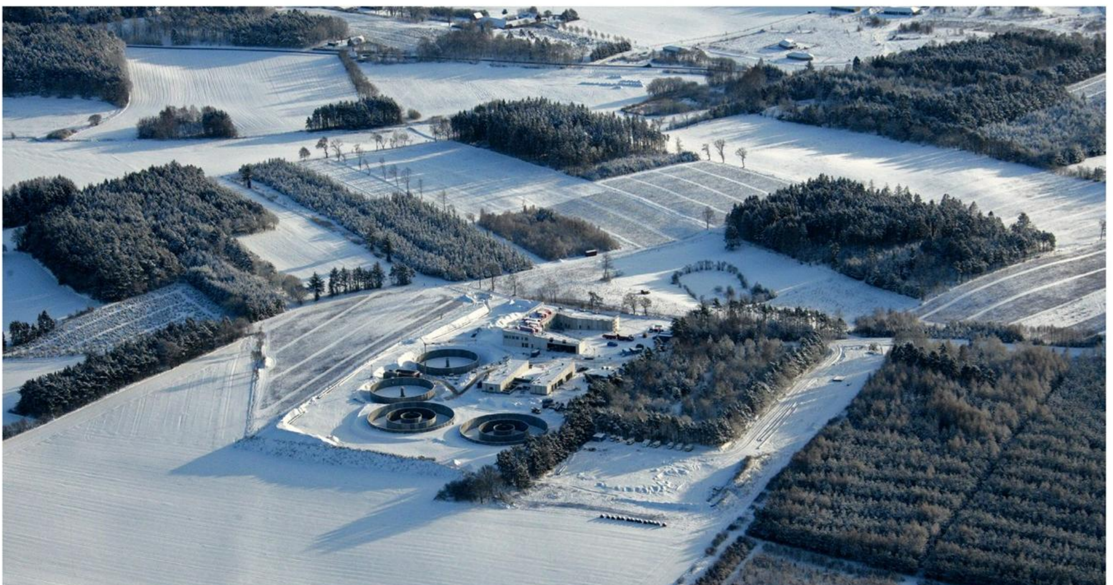
Oversigt over byggeriet i den smukke natur ved Mariager fjord. (Foto: BioDane Luftfoto).
