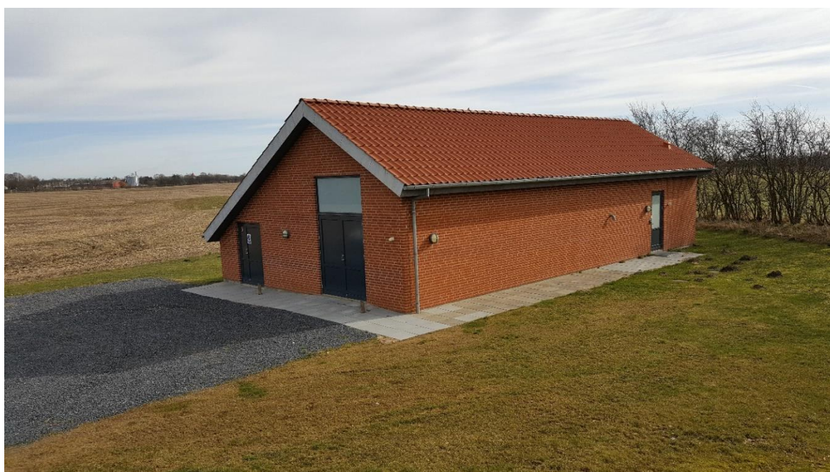
Foto: Skjellerup Vandværk
