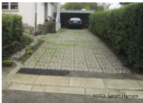
Brede fuger lader vandet sive ned i jorden.
